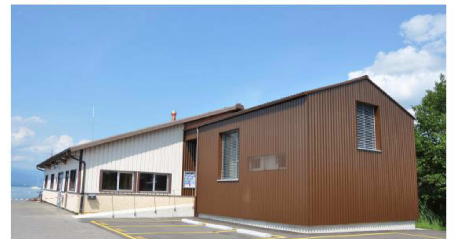
Une nouvelle construction attenante au hangar en place depuis 1986.
